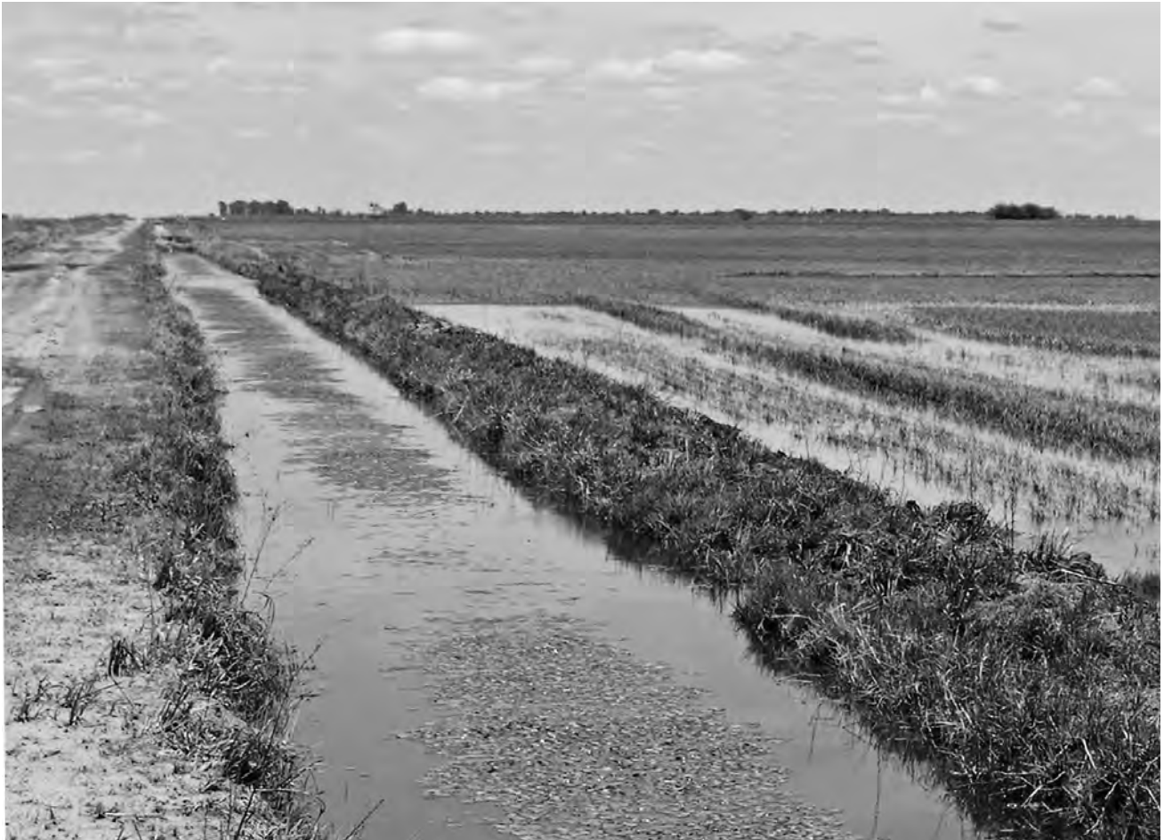
Canal en una arrozcera de San Javier, Santa Fe.
