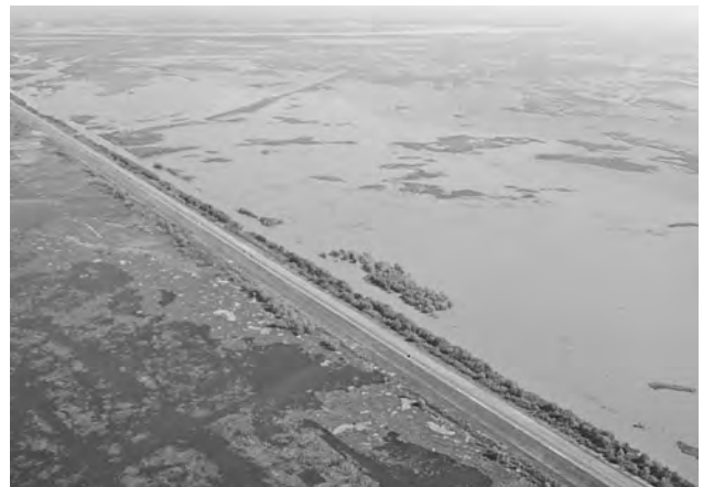
Terraplén de la conexión vial Rosario-Victoria. Se observa la diferencia a uno y otro lado del camino.
