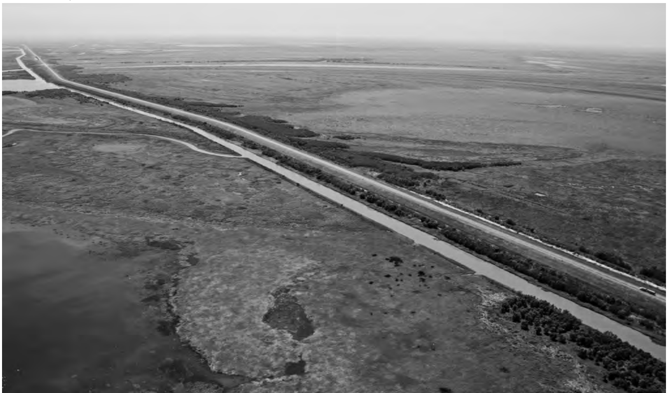
Vista del terraplén del viaducto Victoria-Rosario.
