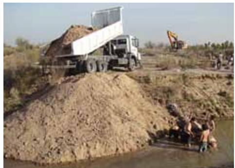
**Figuras 21.-** Trabajo de las máquinas para consolidar el terraplén.
