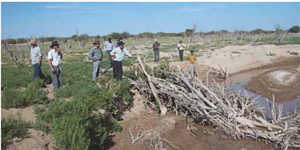
**Figura 4.-** en el sector "Corral de Julia" se observa un pie de gallo hecho con ramas y palos para levantar el nivel de base de un curso de agua del bañado.
