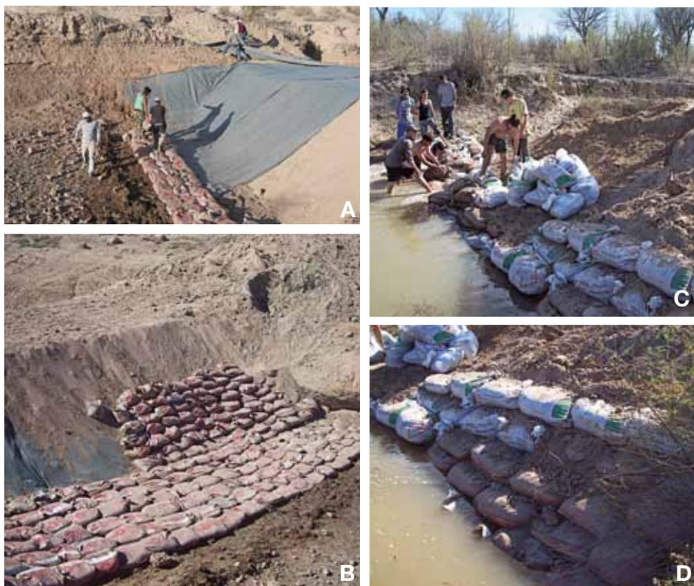
**Figura 24.-** Colocación de bolsas con tierra y rizomas: A) y B) colocación de bolsas en seco; C) y D) colocación de bolsas con presencia de agua en la cárcava.
