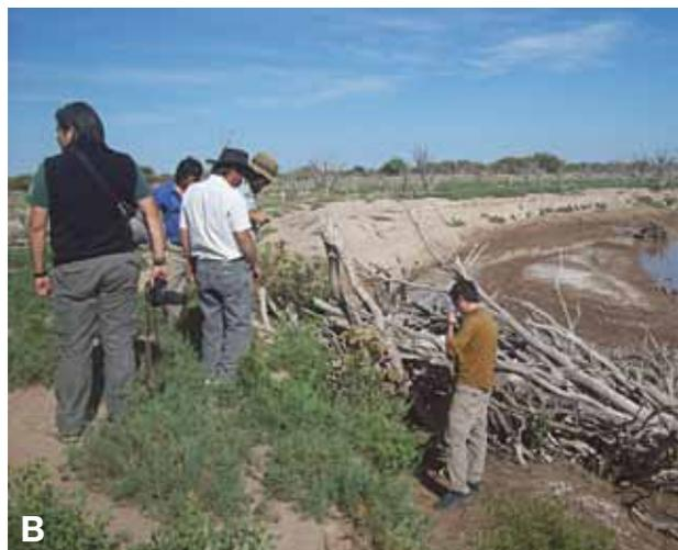
**Figura 3.-** Obras artesanales realizadas por pobladores del Sitio Ramsar para retener o re-encauzar el agua del Bañado de San Miguel: A) canal hecho a pala por los vecinos y B) pie de gallo hecho con ramas y palos para levantar el nivel de un curso de agua del sector “Corral de Julia”.
