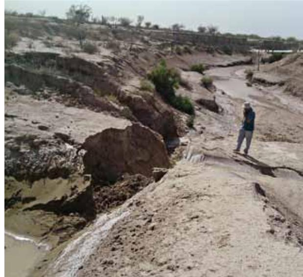
**Figura 29.-** Daño en un extremo del terrapién de La Pasarela ante la ausencia de membrana geotextil.
