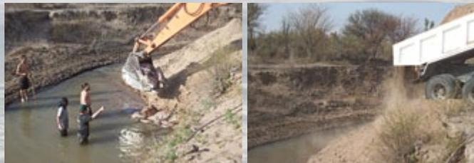
Los terraplenes se revistieron con membrana geotextil, la cual se enterró y fijó al suelo con estacas, para evitar la erosión por el agua.
