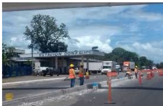
Trabajos de ampliación de vía Panamericana, altura de San Lorenzo, 2016.
