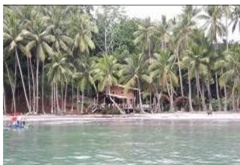
Estructuras construída, en Islas del área de estudio, 2016.
