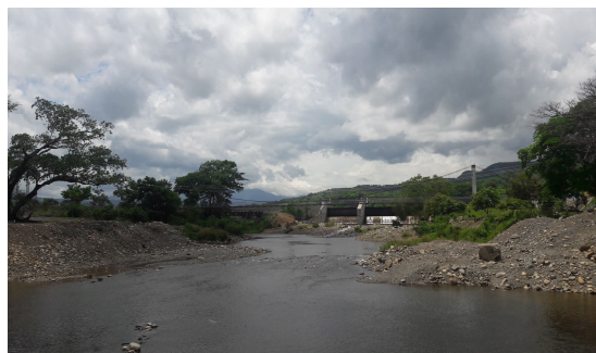
Hidroeléctrica San Lorenzo, río Fonseca, San Lorenzo, 2016.
