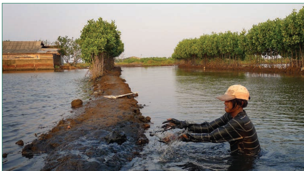
Construcción de piscina de silviacuicultura con manglares en Indonesia.
