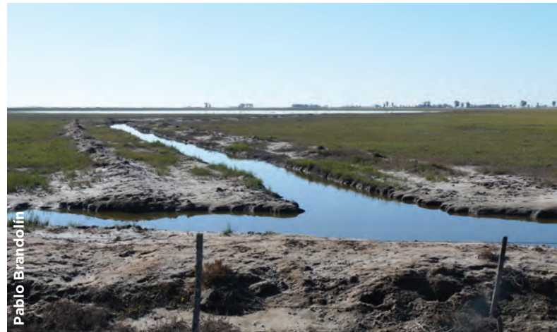
Ejemplo de canalizaciones para drenar una laguna.
