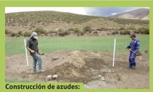
En los sectores erosionados de cursos de agua, se levanta el nivel de base construyendo estos azudes revestidos. Son escalones construidos con material del lugar (tierra, arcilla o turba) revestidos con mantas de geotextil y protegidos por una cubierta de material de suelo superficial. El objetivo es que acumulen el agua de lluvia y los sedimentos que arrastra.
