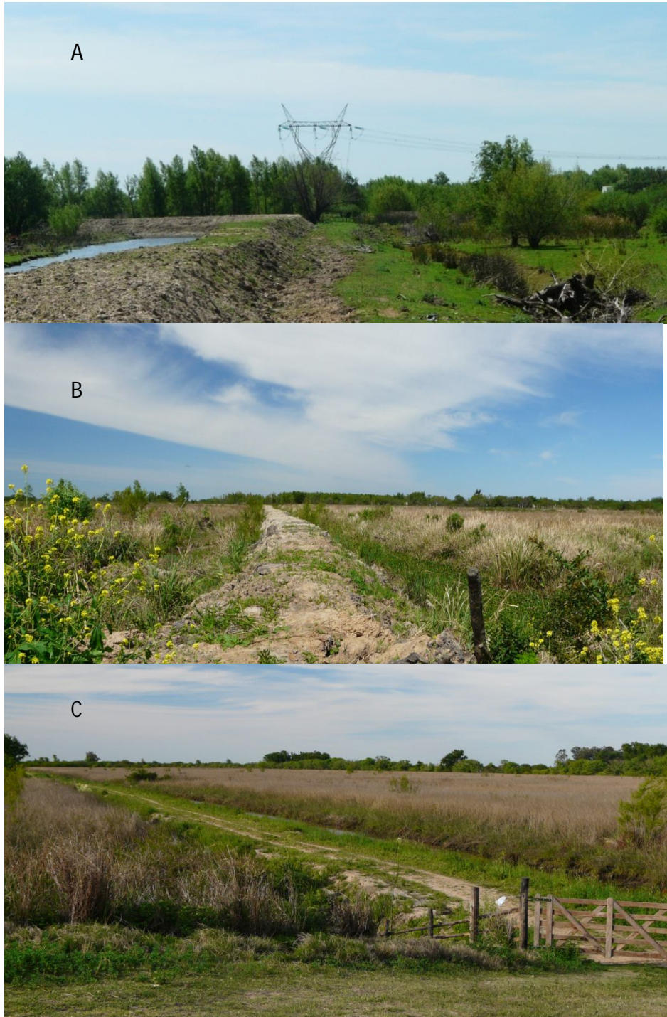
Figura 6.- Usos de terraplenes. A. Perimetrales; B. Internos; C. Caminos y rutas.
