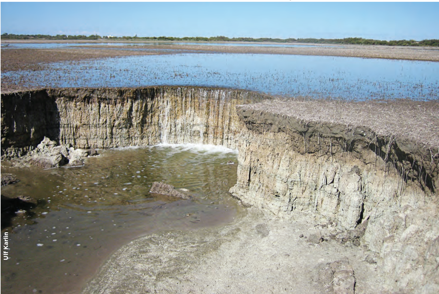
Erosión retrocedente en Lagunas de Guanacache, Mendoza.
