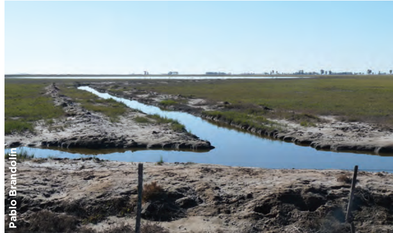
Ejemplo de canalizaciones para drenar una laguna.
