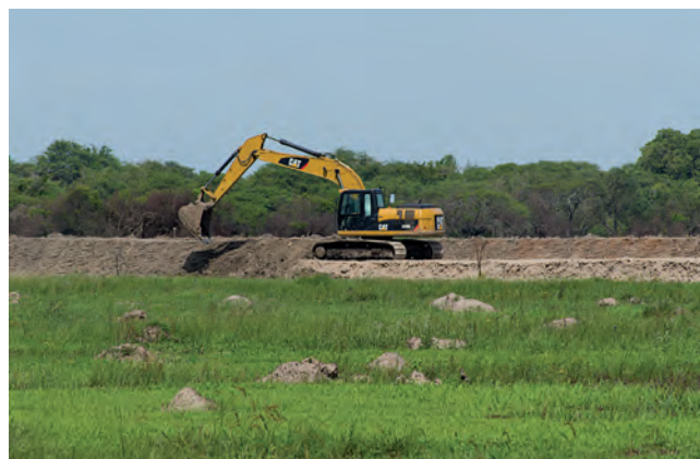
Construcción de terraplén para arrozera, San Javier, Santa Fe.
