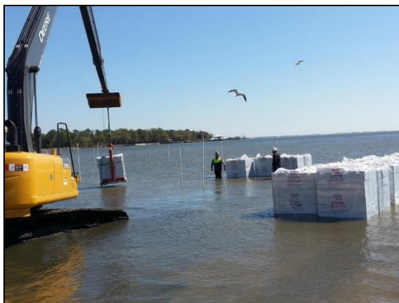
Imagen N°8.2. Construcción de castillos de ostras. Orden: Imágenes superiores: Estructura con conchas de ostras; imágenes inferiores: Arrecifes artificiales para los castillos de ostras. Fuente: Building with Nature: Thinking, acting and interacting differently. Ecoshape 2012. Compañía Allied Concrete, Charlottesville, Virginia, EEUU 2018.
