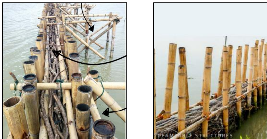
Imagen N°8.5. Estructura de barreras permeables. Fuente: Permeables Structures, 2020 © Joost Fluitsma – JAM Visual Thinking.
