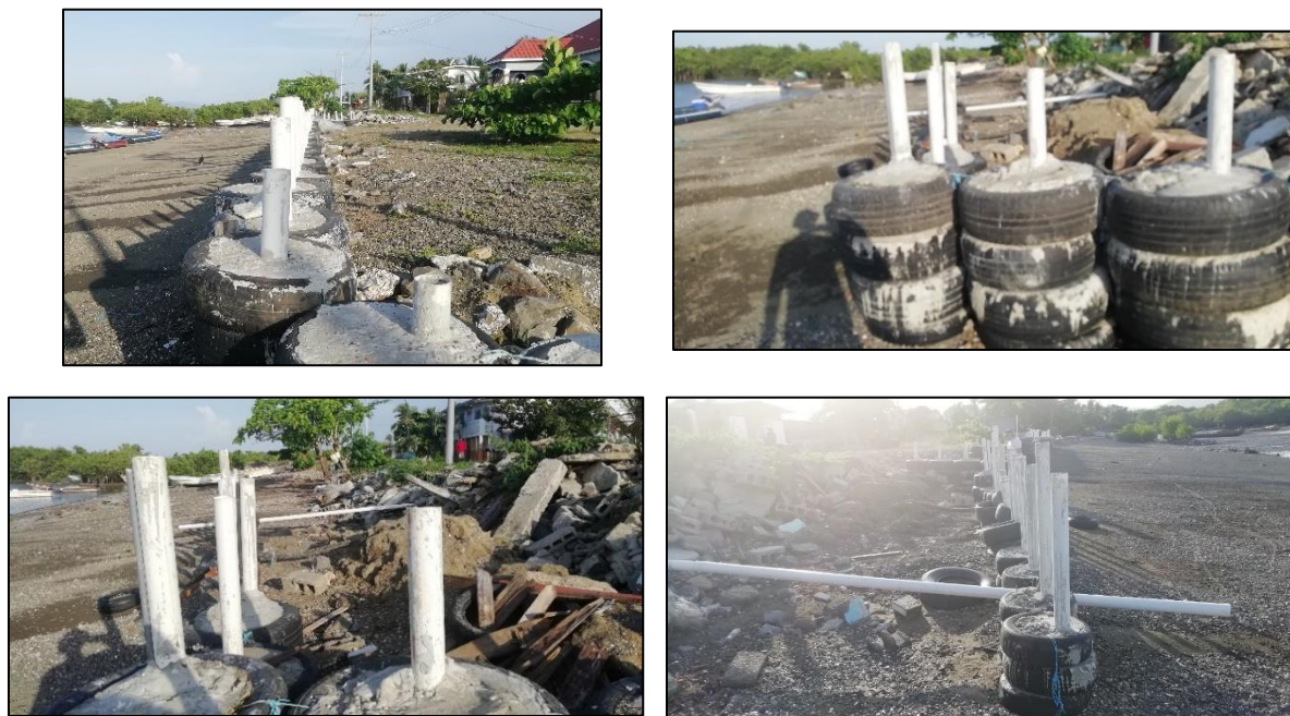
Imagen N°8.8. Barrera de neumáticos en la costa de Garachiné como medida de protección contra inundaciones. Fuente: Proyecto Levantamiento de un Diagnóstico Participativo Sobre Afectaciones en Medios de Vida de la Comunidad de Garachiné Asociada a la Erosión Costera y Elaboración de Estrategia y Plan de Acción Comunitario. Fundación Wetlands International, 2019-2020.
