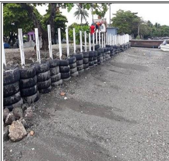
Colocación de llantas como barreras de contención para evitar el avance del litoral.
