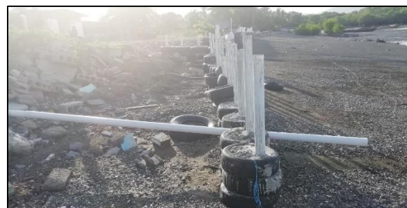
Imagen A1.3. Ejemplo del uso de barrera de neumáticos en la comunidad de Garachiné. Fuente: Proyecto Levantamiento de un Diagnóstico Participativo Sobre Afectaciones en Medios de Vida de la Comunidad de Garachiné Asociada a la Erosión Costera y Elaboración de Estrategia y Plan de Acción Comunitario. Fundación Wetlands International, 2019-2020.
