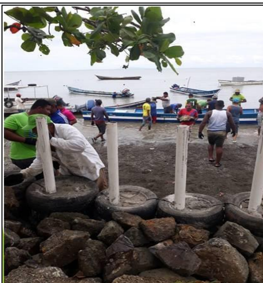
Colocación de llantas como barreras de contención para evitar el avance del litoral.
