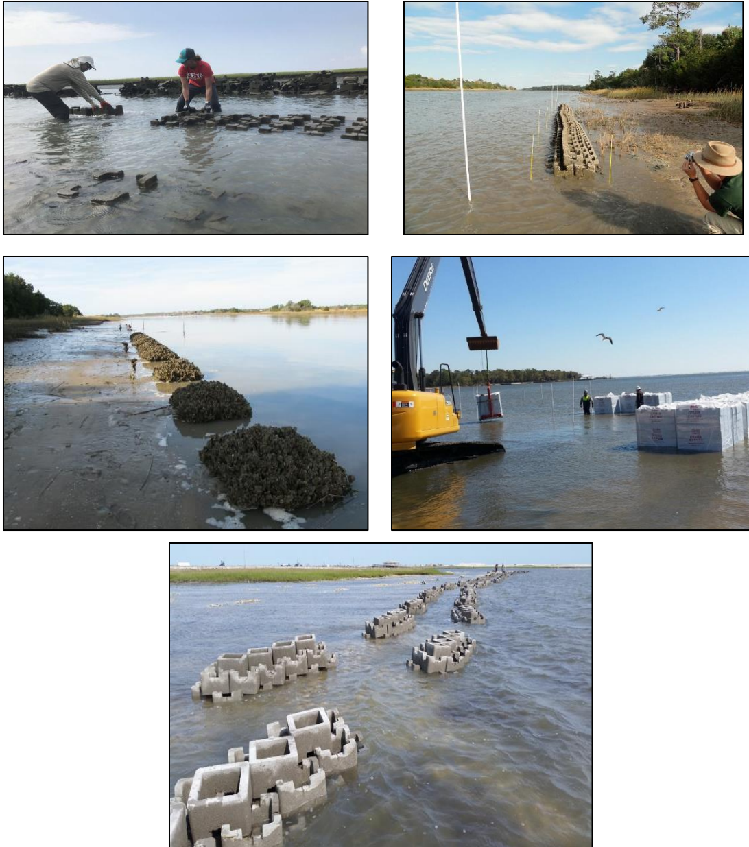
Imagen A1.2. Ejemplo del uso de castillos de ostras para protección costera. Fuente: Building with Nature: Thinking, acting and interacting differently. Ecoshape 2012. Compañía Allied Concrete, Charlottesville, Virginia, EEUU 2018.
