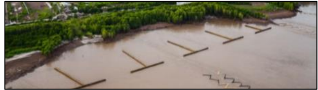
Imagen N°3. Ejemplo del uso de las barreras permeables para protección costera. Fuente: Wetlands International, 2017.
