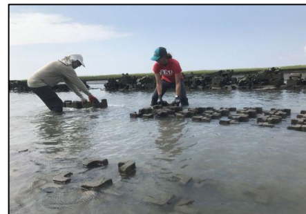
Imagen N°4. Ejemplo del uso de castillos de ostras para protección costera. Fuente: Wetlands International, 2017.
