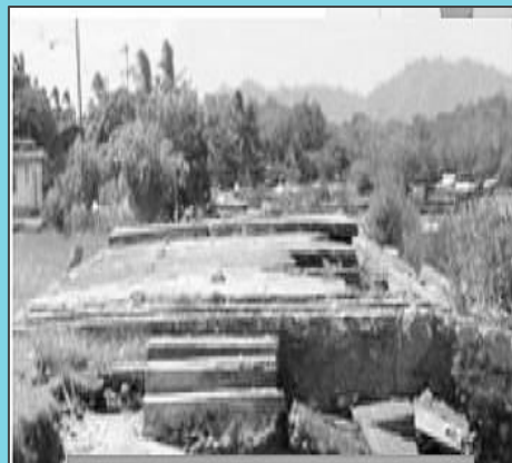
Escombros de la antigua iglesia.
