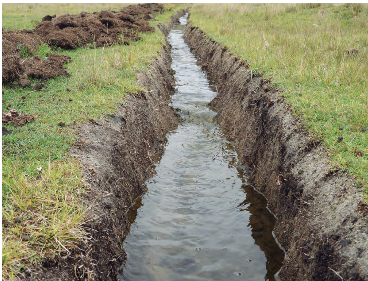
Construcción de canales de riego superficiales.
