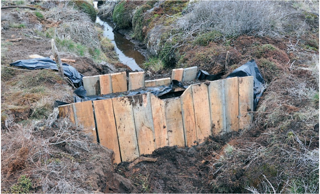
Figura 7.- Cierre de doble tablestacado en proceso constructivo. Presenta un vertedero en su parte superior para evacuar excedentes de agua.
