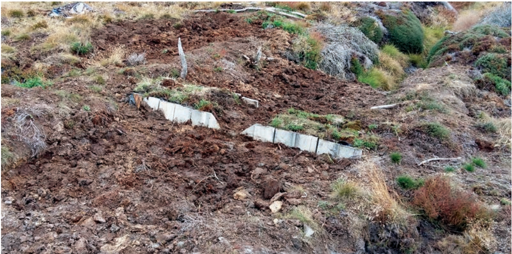
Figura 9.- Vista del cierre de tablestacado de madera concluido, con relleno de turba a ambos lados. Se ha practicado un corte en la parte superior para canalizar excedentes de escurrimiento y se ha vegetado el coronamiento para reducir la erosión.
