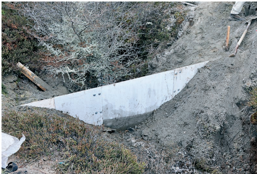
Figura 6.- Tablero de fibrocemento con placas superpuestas. Deben ser unidas después de la colocación para evitar roturas durante el hincado.
