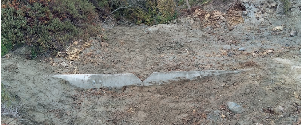
Figura 13.- Cierre con vertedero triangular para regulación y medición del escurrimiento.
