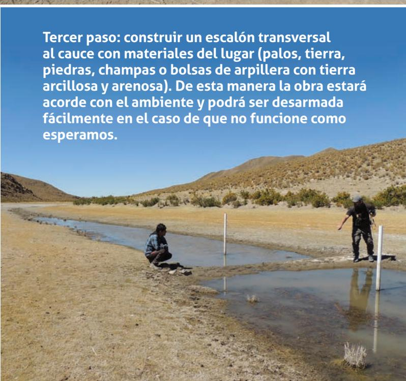
**Tercer paso:** construir un escalón transversal al cauce con materiales del lugar (palos, tierra, piedras, champas o bolsas de arpillera con tierra arcillosa y arenosa). De esta manera la obra estará acorde con el ambiente y podrá ser desarmada fácilmente en el caso de que no funcione como esperamos.
