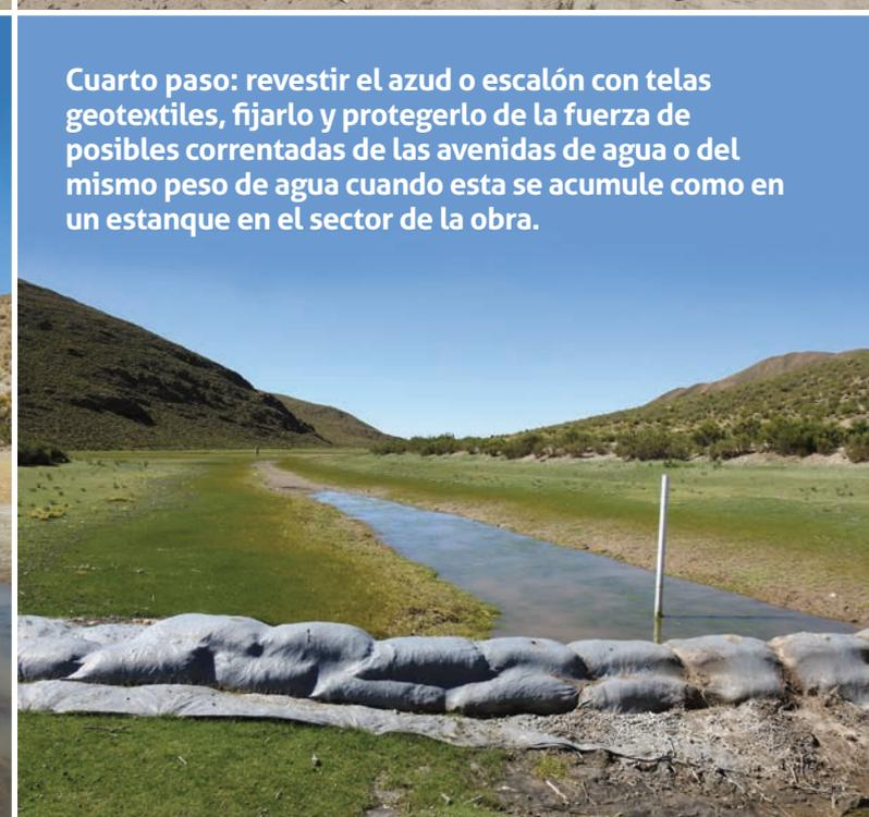
**Cuarto paso:** revestir el azud o escalón con telas geotextiles, fijarlo y protegerlo de la fuerza de posibles correntadas de las avenidas de agua o del mismo peso de agua cuando esta se acumule como en un estanque en el sector de la obra.
