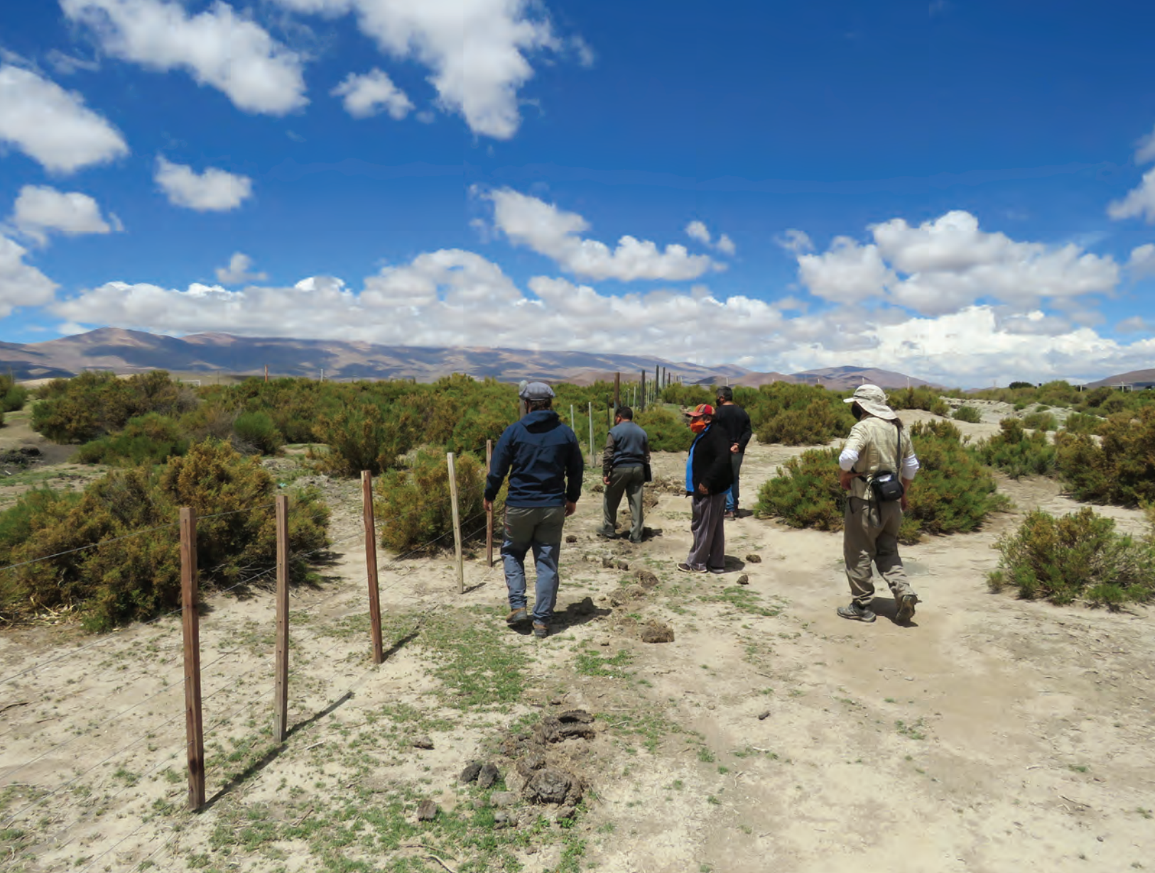
Construcción de "clausuras o cierres perimetrales" junto a alumnos de la escuela Agrotécnica en sectores de la vega sobrepastoreados
