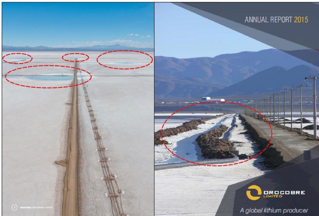
Figura 5. Precarias obras de infraestructura caminera. A la izquierda se observan endicamientos producidos por un camino y a la derecha una intervención para que la inundación no afecte el camino.
