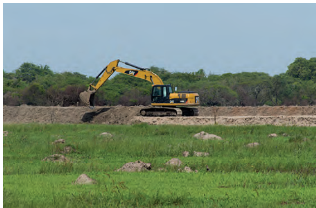
Construcción de terraplén para arrozcerá, San Javier, Santa Fe.
