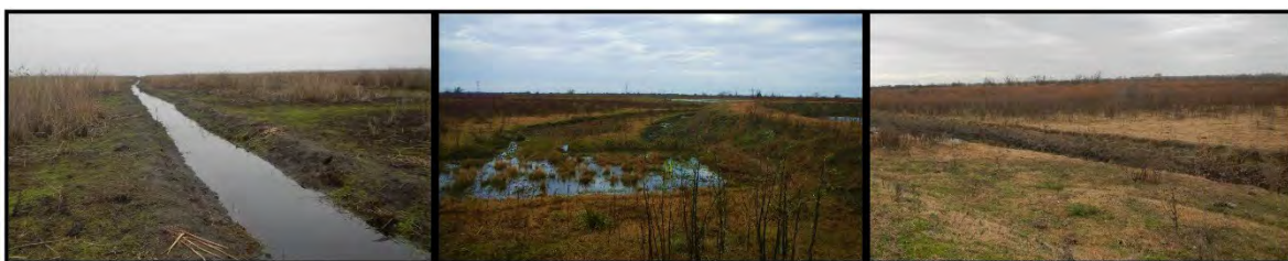
Obras de infraestructura para el manejo del agua en el Bajo Delta del río Paraná. Estas obras se encuentran destinadas a prevenir el ingreso de agua o facilitar su drenaje durante los períodos de aguas altas. De izquierda a derecha: canalización, terraplén, endicamiento (Fotos: Diego S. Aquino).
