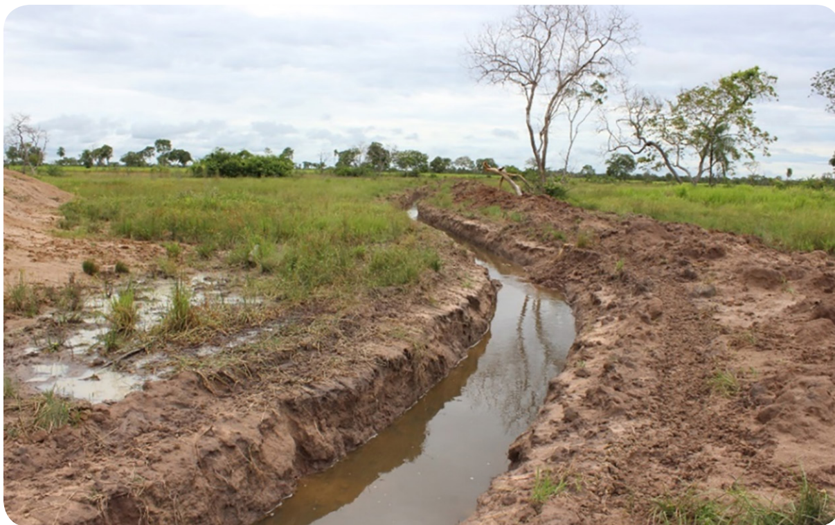
Figura 9.- Vista de uma obra de drenagem na planície pantaneira do município de Cáceres MT
